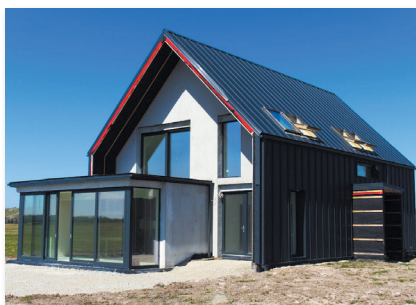
Fot. 1. Elewacja południowo-wschodnia budynku pasywnego
