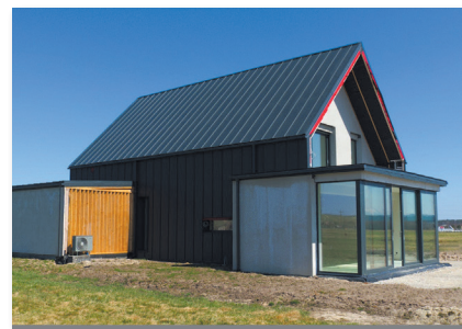
Fot. 2. Elewacja południowo-zachodnia budynku pasywnego
